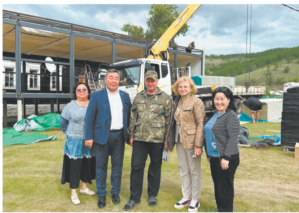
Галина Кудрявцева оценила, как идёт строительство пищеблока для школы
