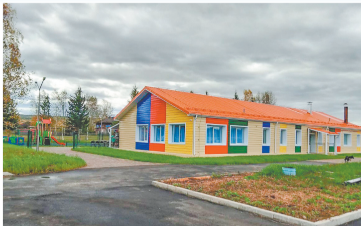
Поликлиника в Усть-Илимске в процессе ремонта
