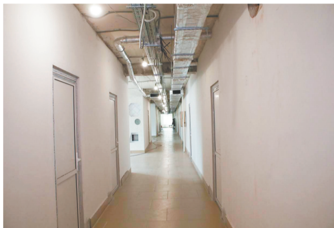
Поликлиника в Усть-Илимске в процессе ремонта
